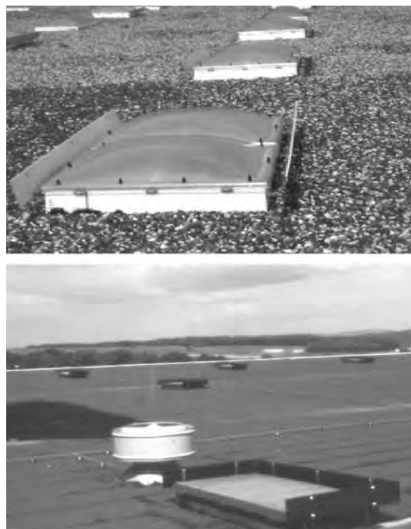
Abbildung 5: Dachaufbauten: Rauch- und Wärmeabzugsanlagen
